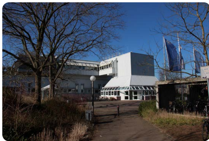
Außenaufnahme des Versorgungszentrums des UK Heidelberg
