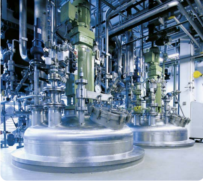
Chemieanlage der Siegfried AG in Zofingen
